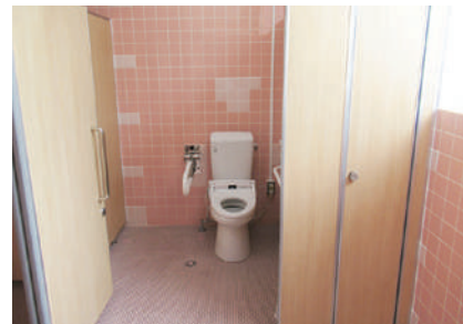
◀運動場トイレの改修
